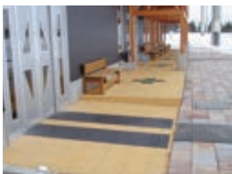
●中標津町／スケートリンクハウス
