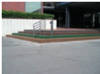
●南富良野／総合福祉センター
